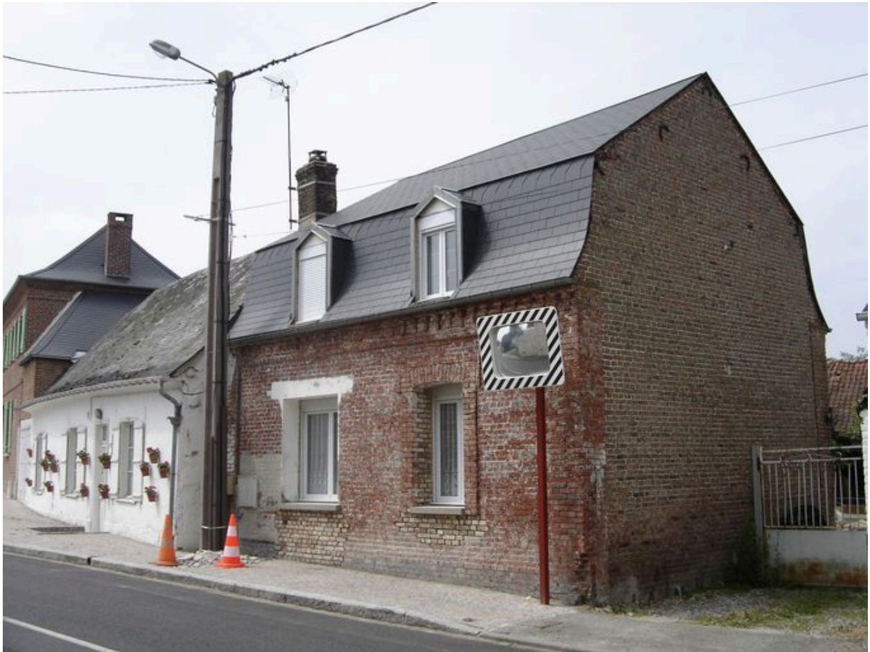
Vue du logis aujourd'hui situé au n°158 route de Gamaches.
