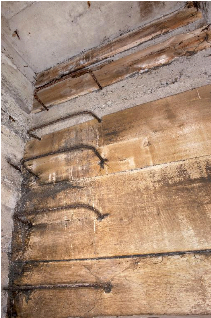
Vue intérieure : échelons métalliques et coffrage
