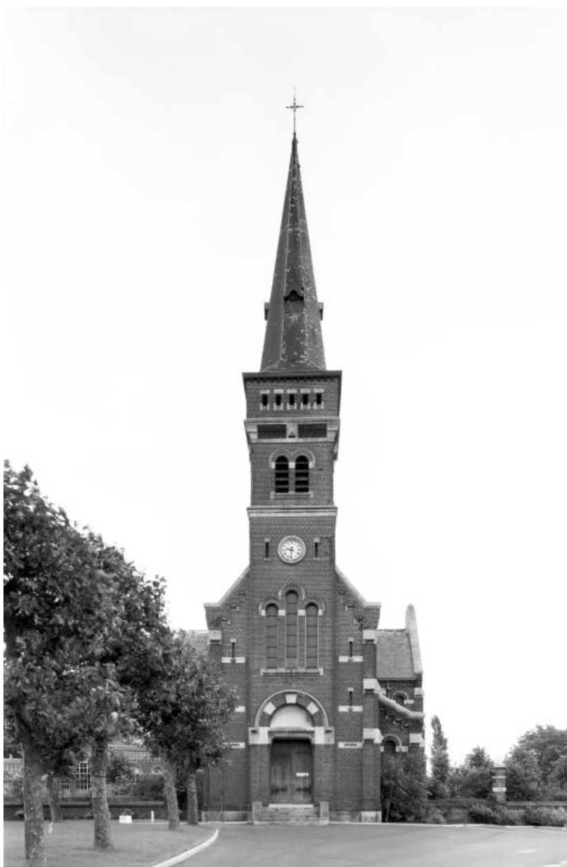
Vue générale, vers l'est.
