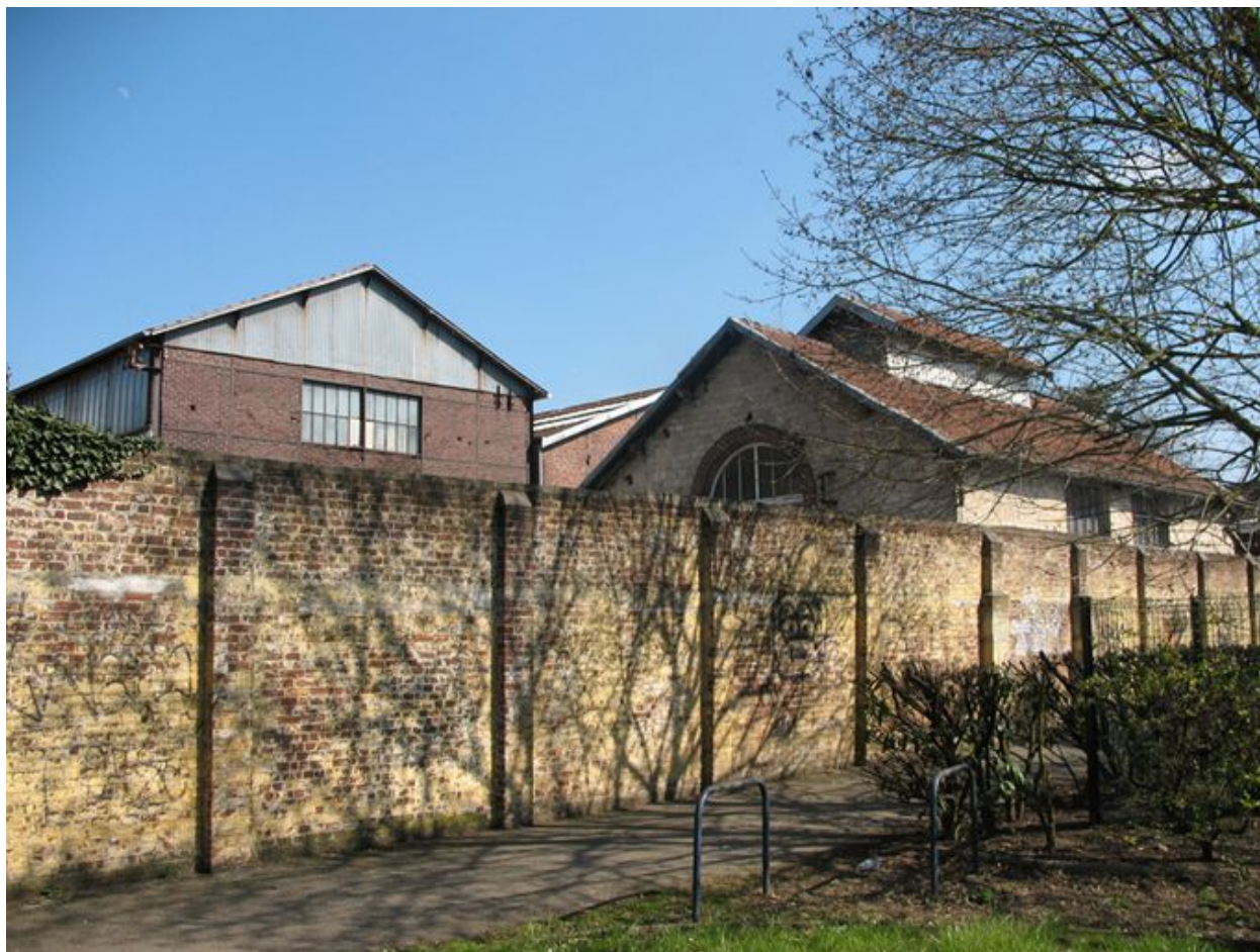
Mur de clôture à l'ouest.
