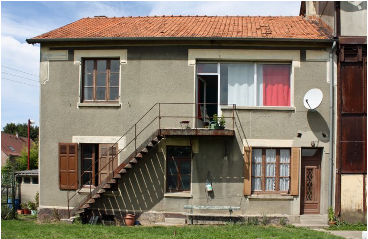
Logement et bureaux, façade postérieure.
