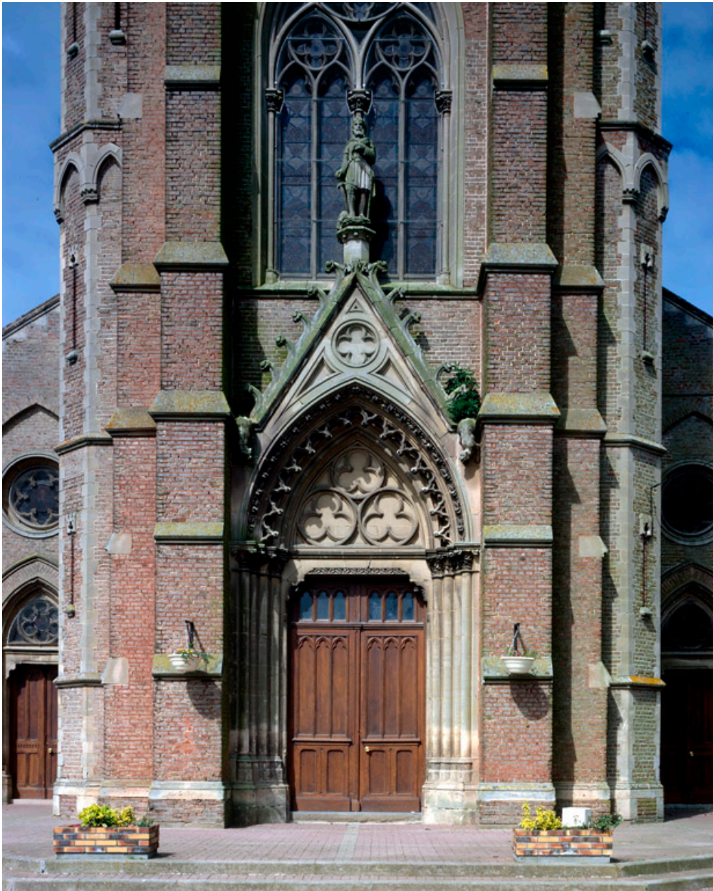
Détail du portail occidental.
