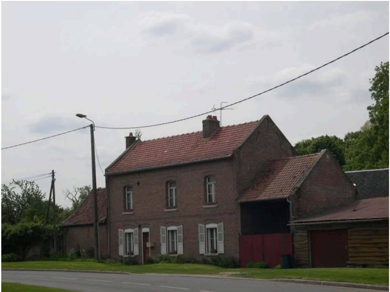
Maison, 12 rue de l'Eglise.
