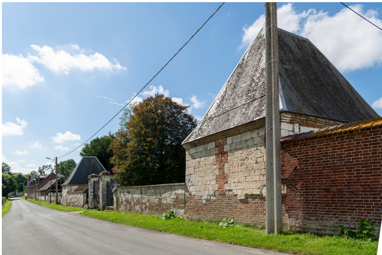
Pavillons et mur de clôture alignés sur la rue, vue depuis le nord-est.
