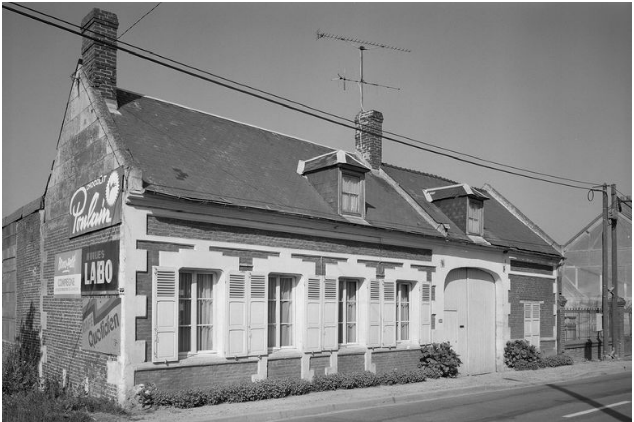
Logis. Elévation sur rue.
