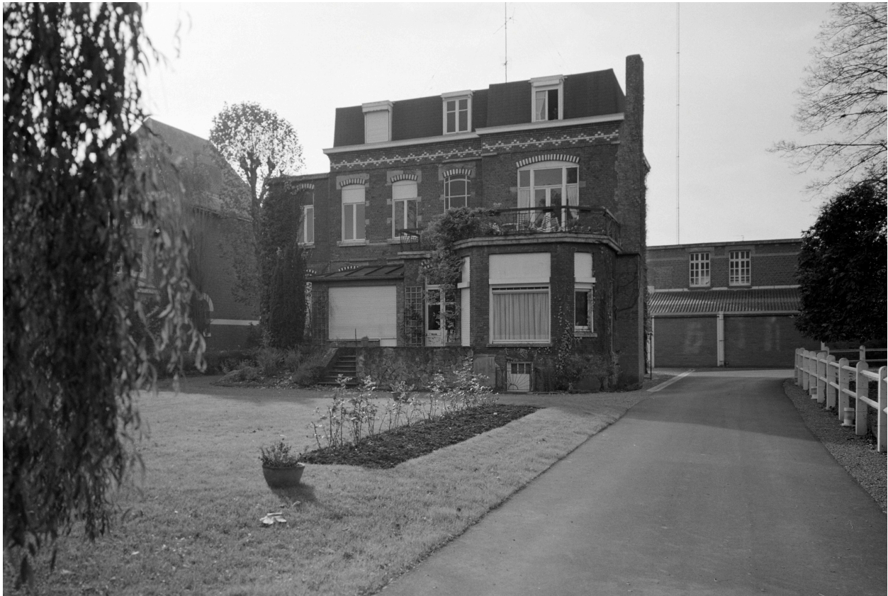
Logement patronal, élévation postérieure.
