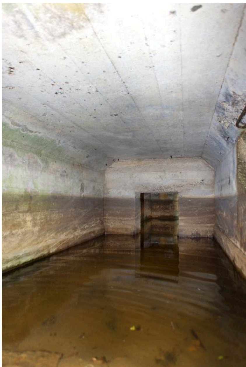
Vue en enfilade des deux salles de l'abri, depuis l'entrée ouest
