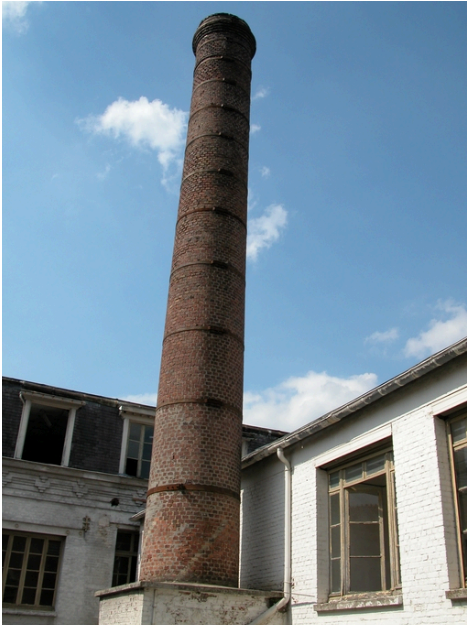
La cheminée d'usine.
