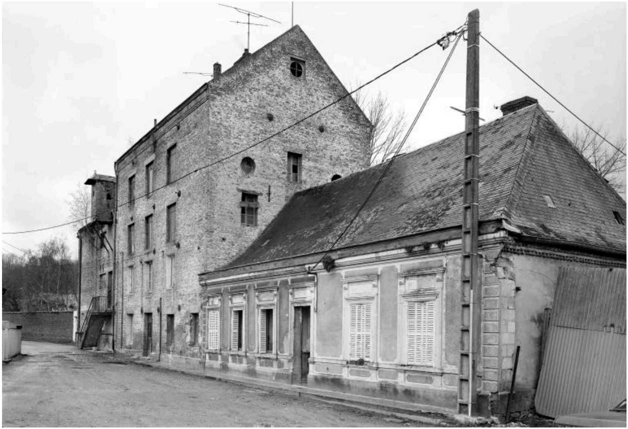
Vue des façades du moulin à farine et du logis.
