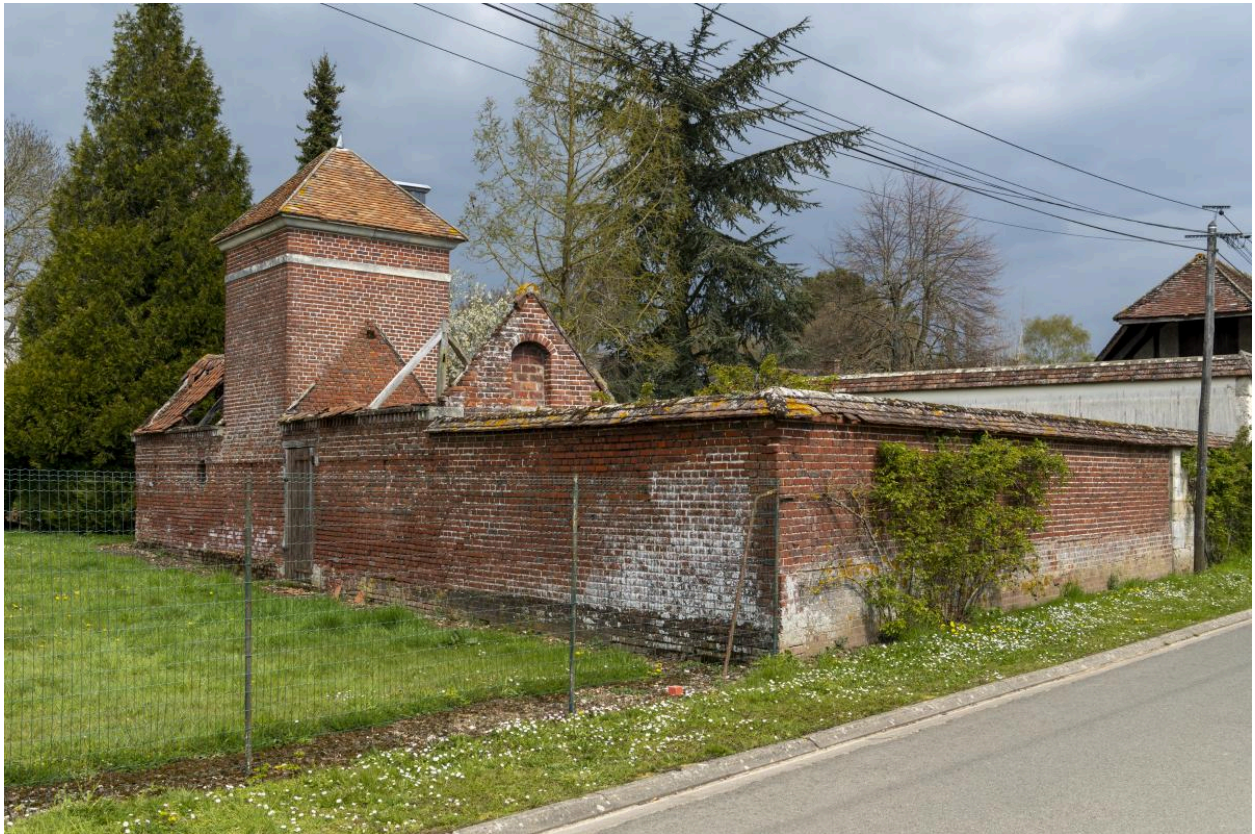
Clôture d'une ancienne ferme avec pigeonnier et bâtiment, n°22 rue de Bonlier, vue depuis le sud-ouest.
