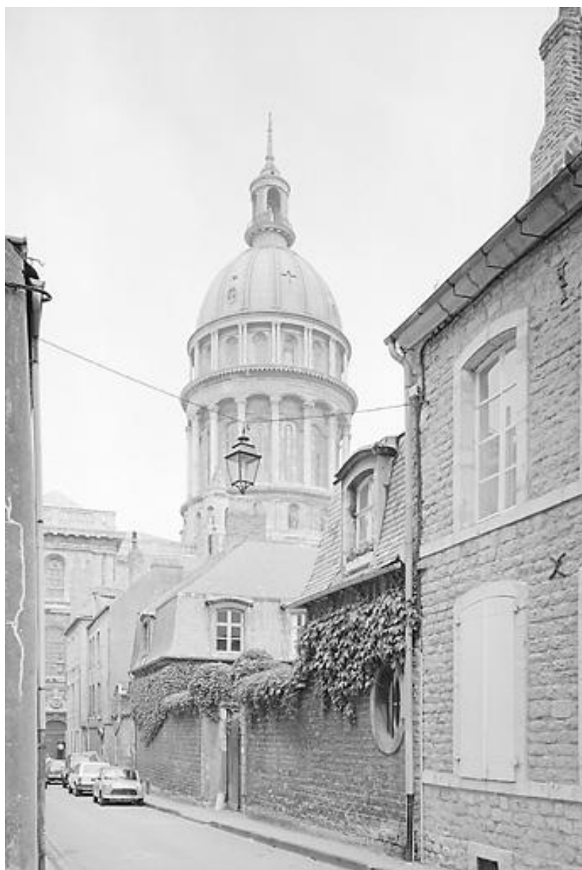
Vue générale sur voie.
