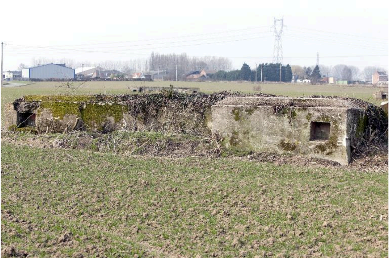
Ouvrage, en L, vers l'ouest
