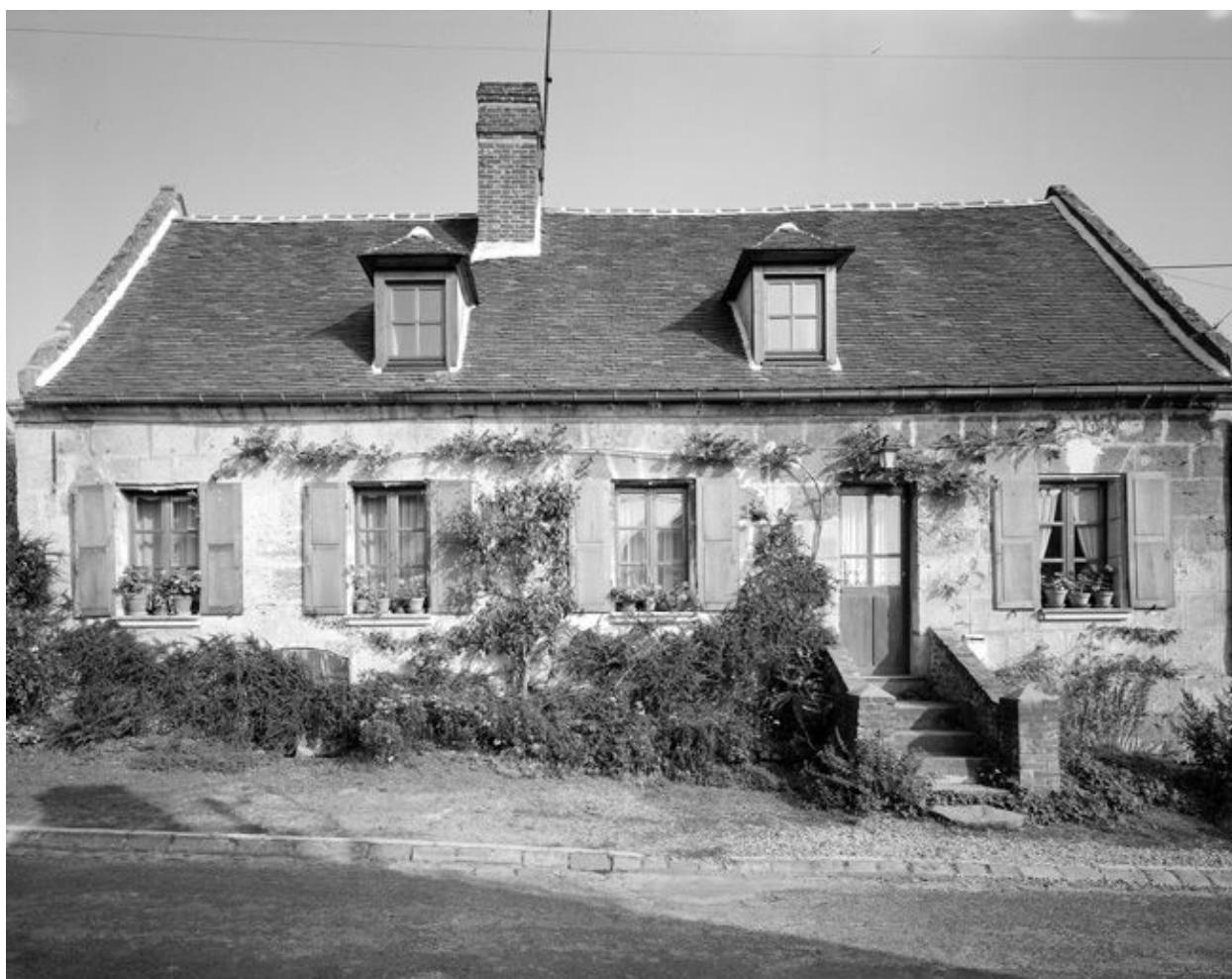
Logis. Vue générale.
