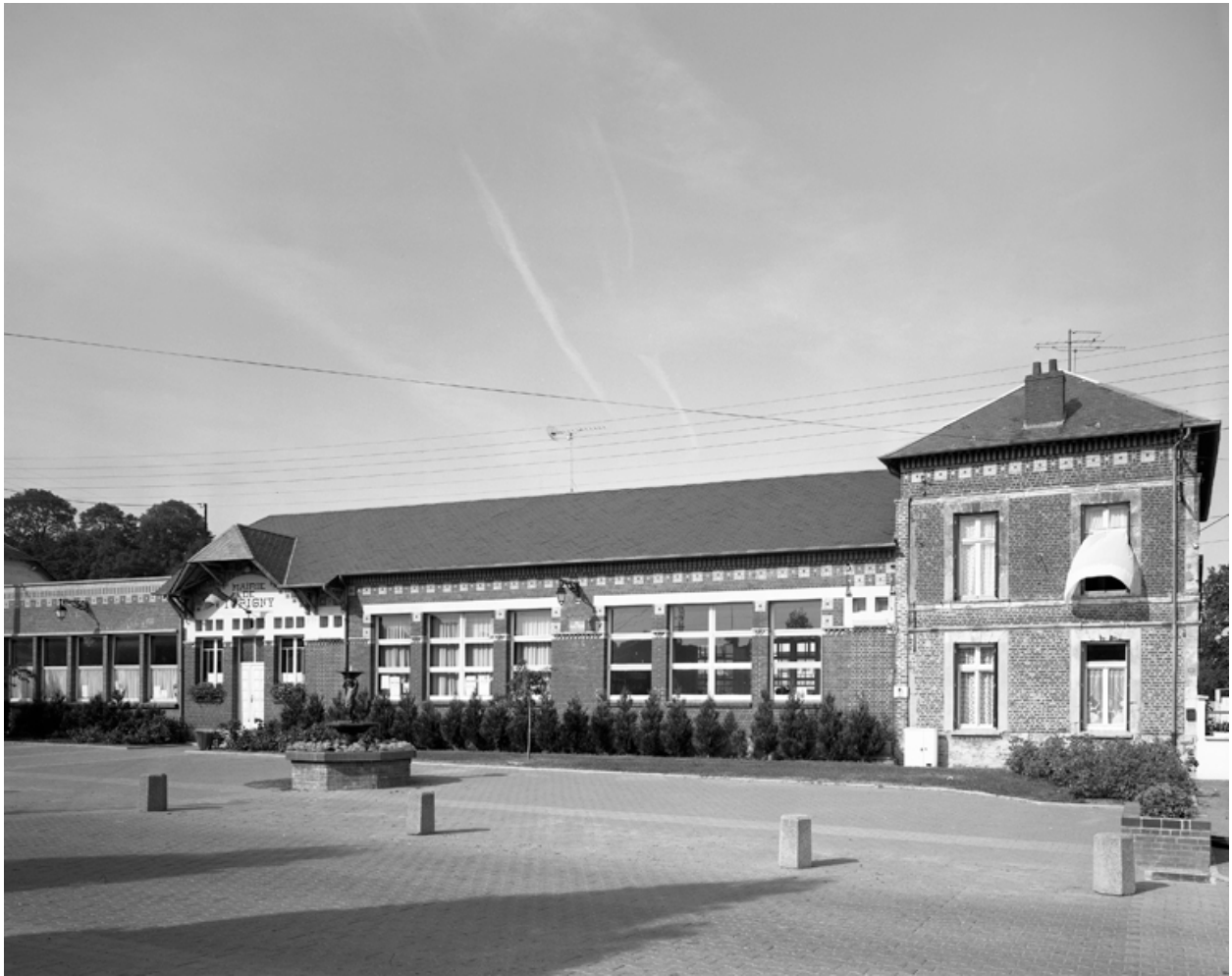
Vue d'ensemble de la façade.
