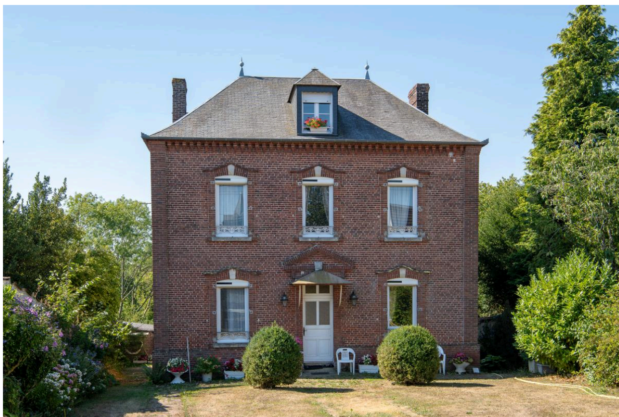
Ancien presbytère, n° 18 rue Pauvrette, vue depuis le nord.
