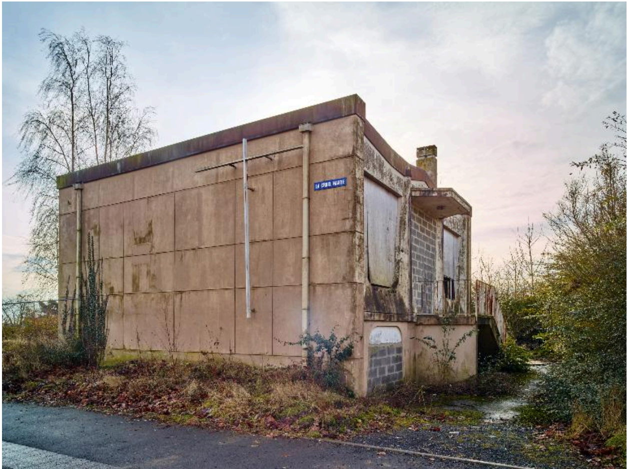
Élévation nord et ouest de l'édifice.
