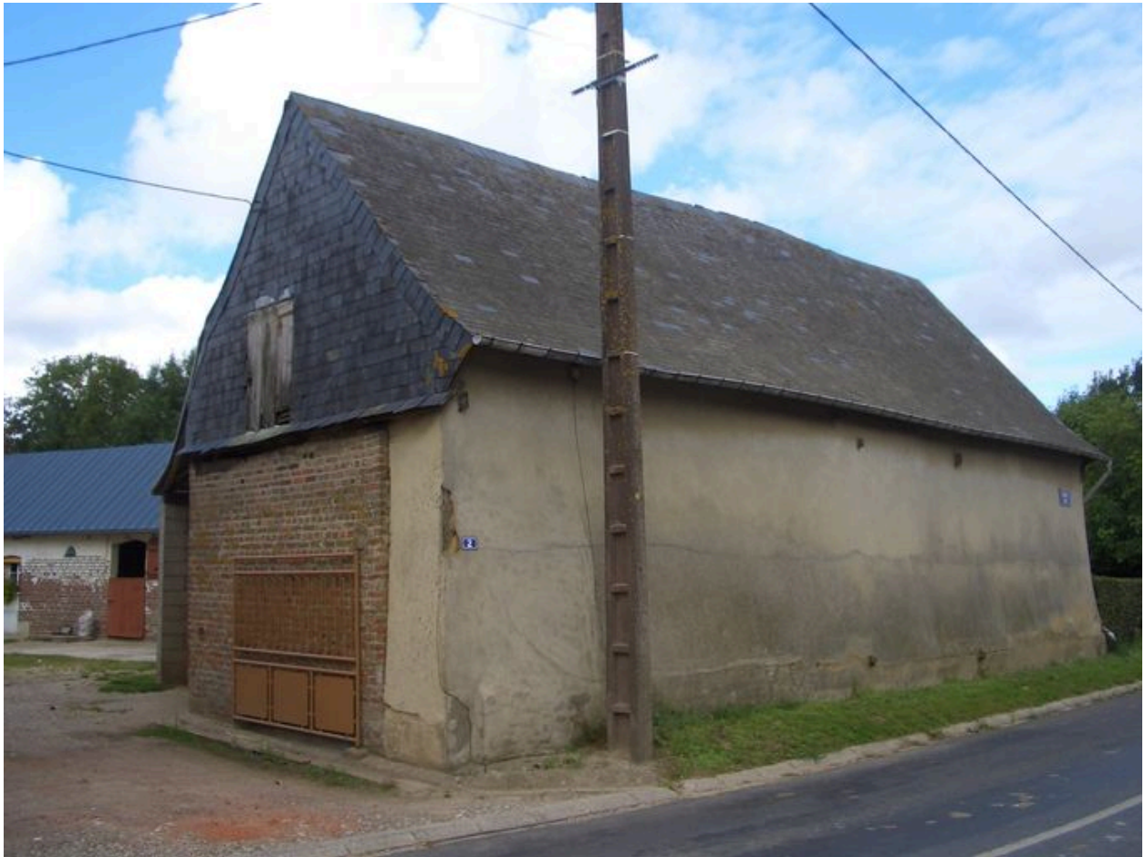
Vue depuis la rue de la grange nord.
