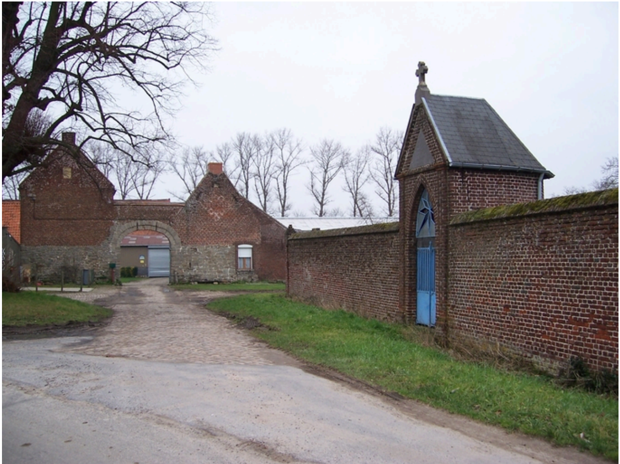
Ferme de Hongrie, vue générale.
