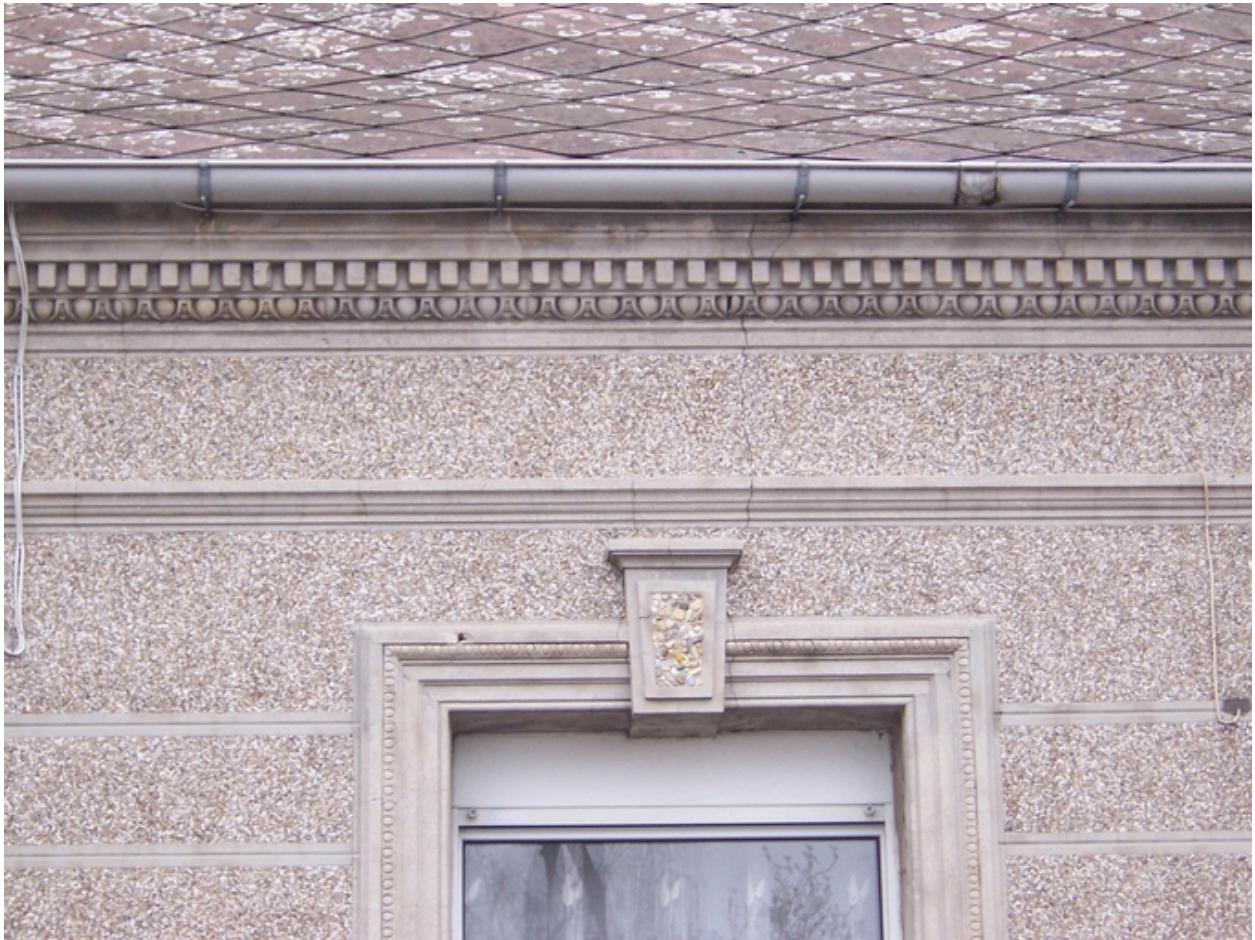
Détail de la façade en gravier roulé.
