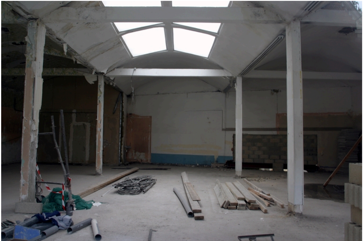
Vue intérieure des ateliers de la rue de Bellevue.
