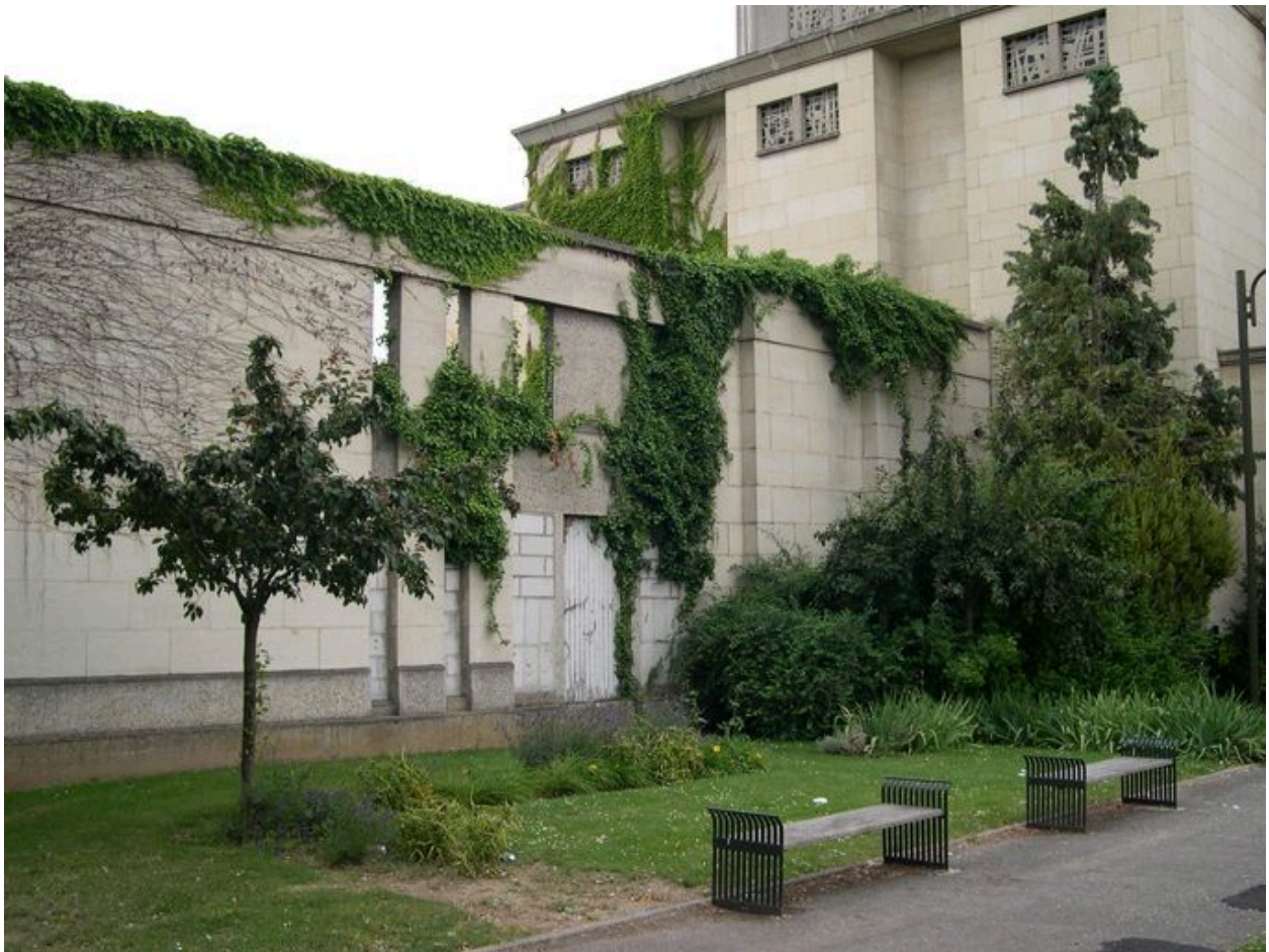
Vue générale depuis le sud-est : mur du jardin du presbytère.
