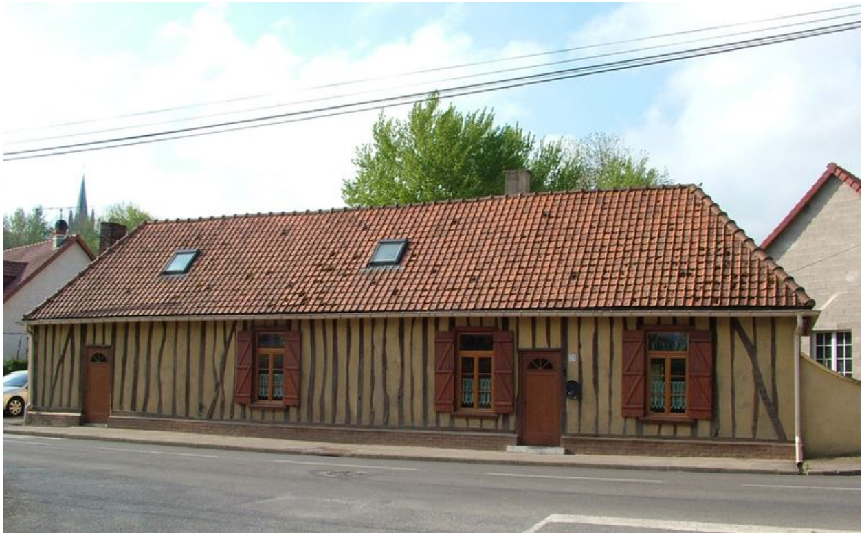
Havernas, ancienne auberge, 21 rue de la Carrière, 19e siècle.
