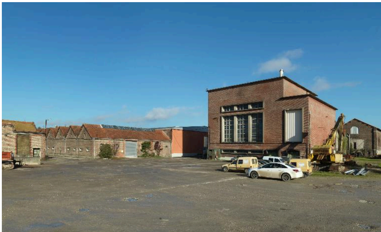
Ancienne chaufferie à charbon et son aire de matière première, vue d'ensemble de trois quarts.
