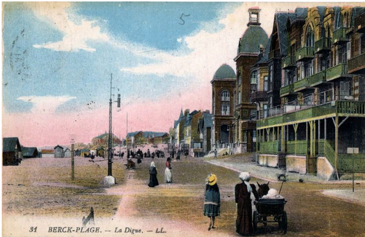
Le digue du front de mer.
