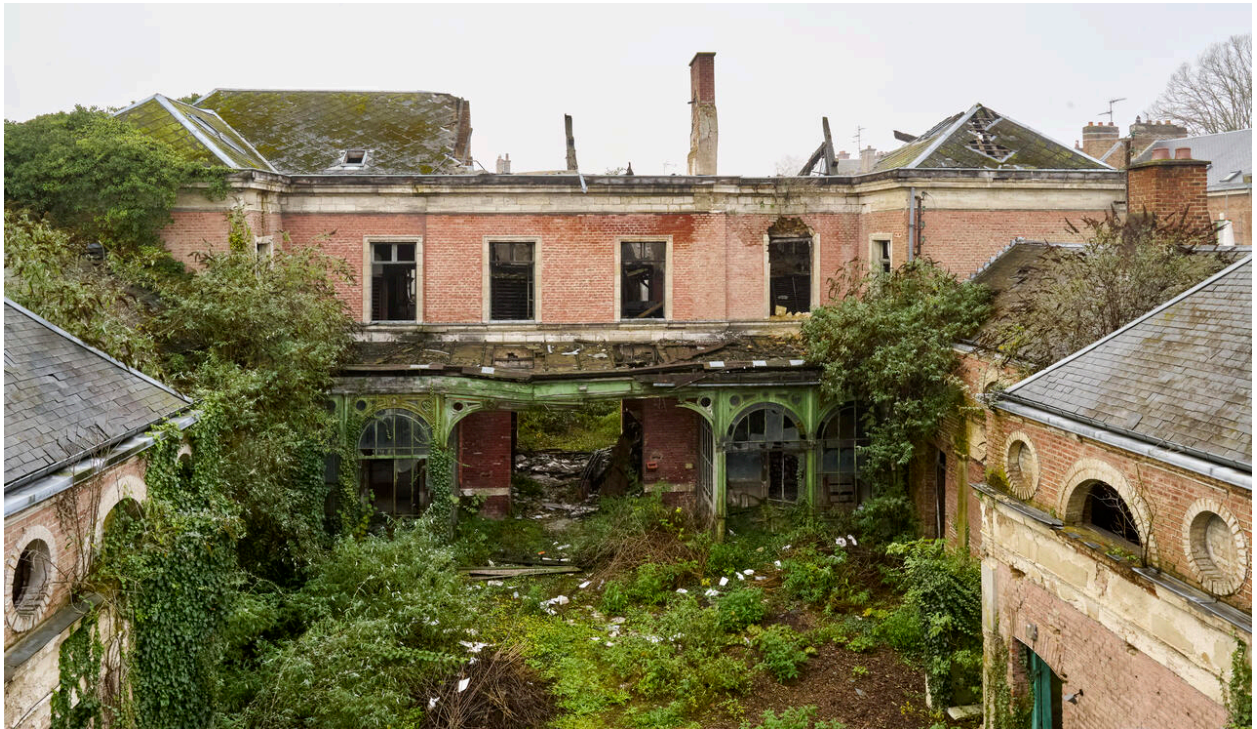
Vue générale depuis la rue Vivien (nord).
