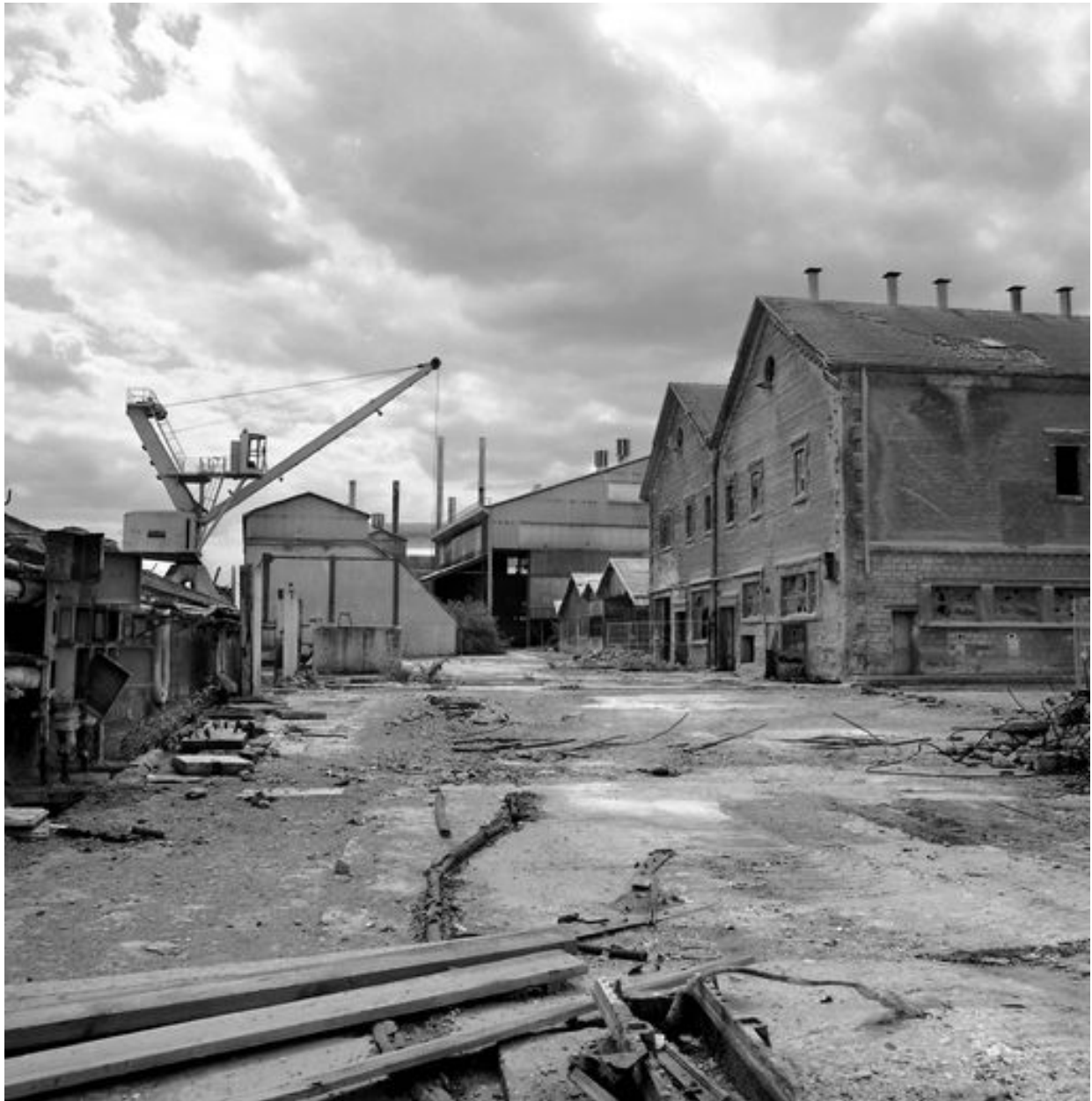
Vue vers l'ouest du bâtiment des chaudières et des fours (à droite), des zones de stockage des minerais et de la grue (à gauche), en 1999.
