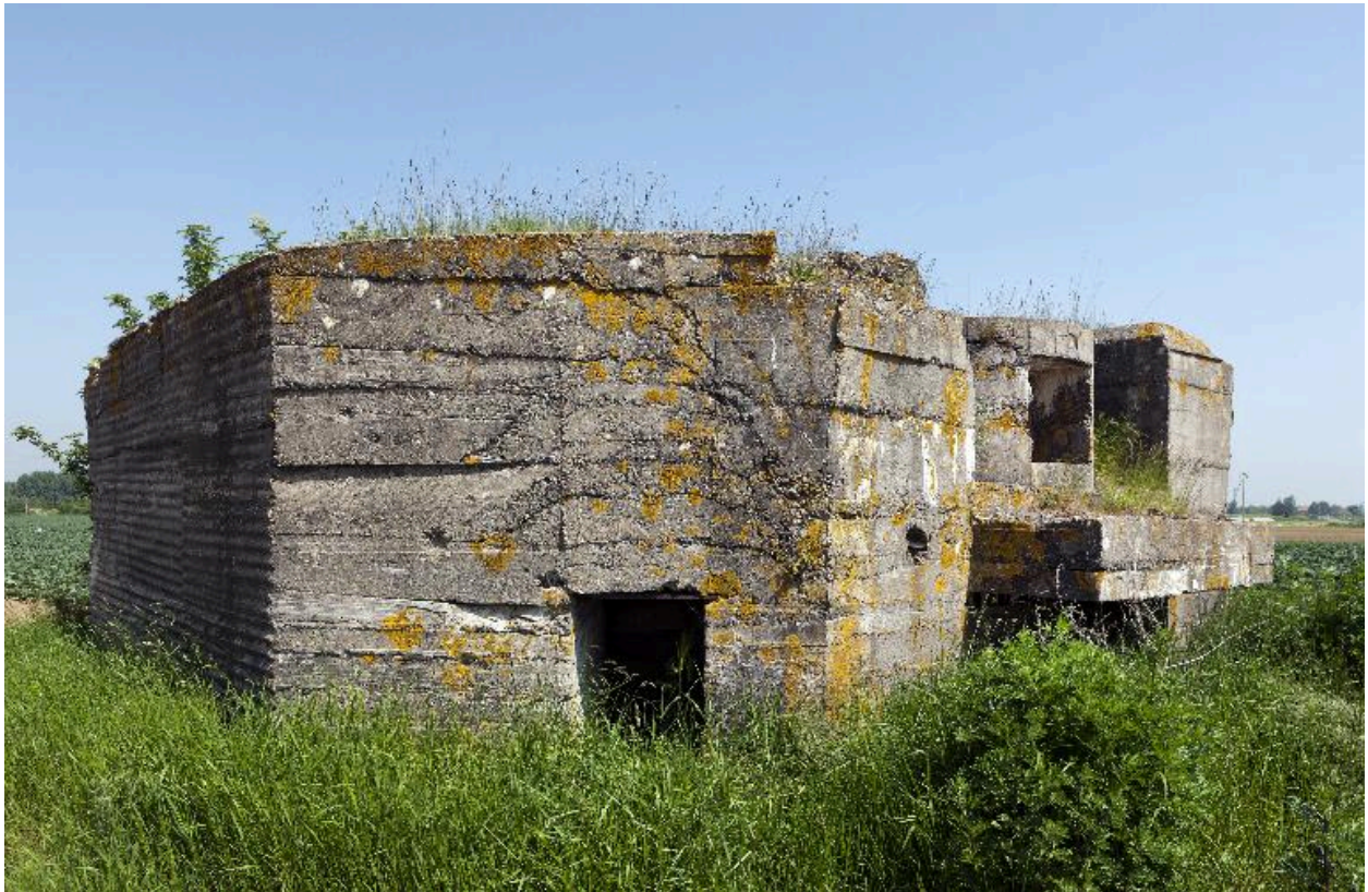
Vue de trois-quarts, vers le nord. Entrée sud-est
