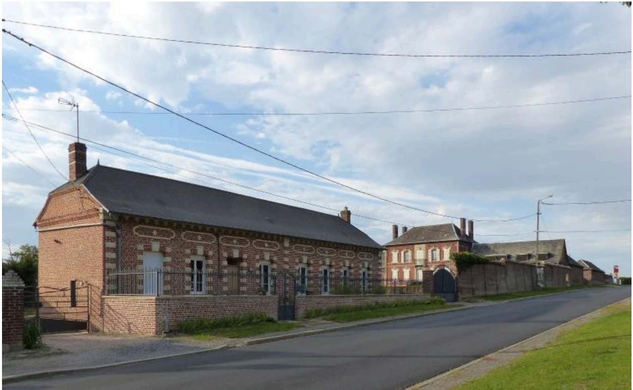
Vue de situation, depuis la route de Péronne, du sud-est.
