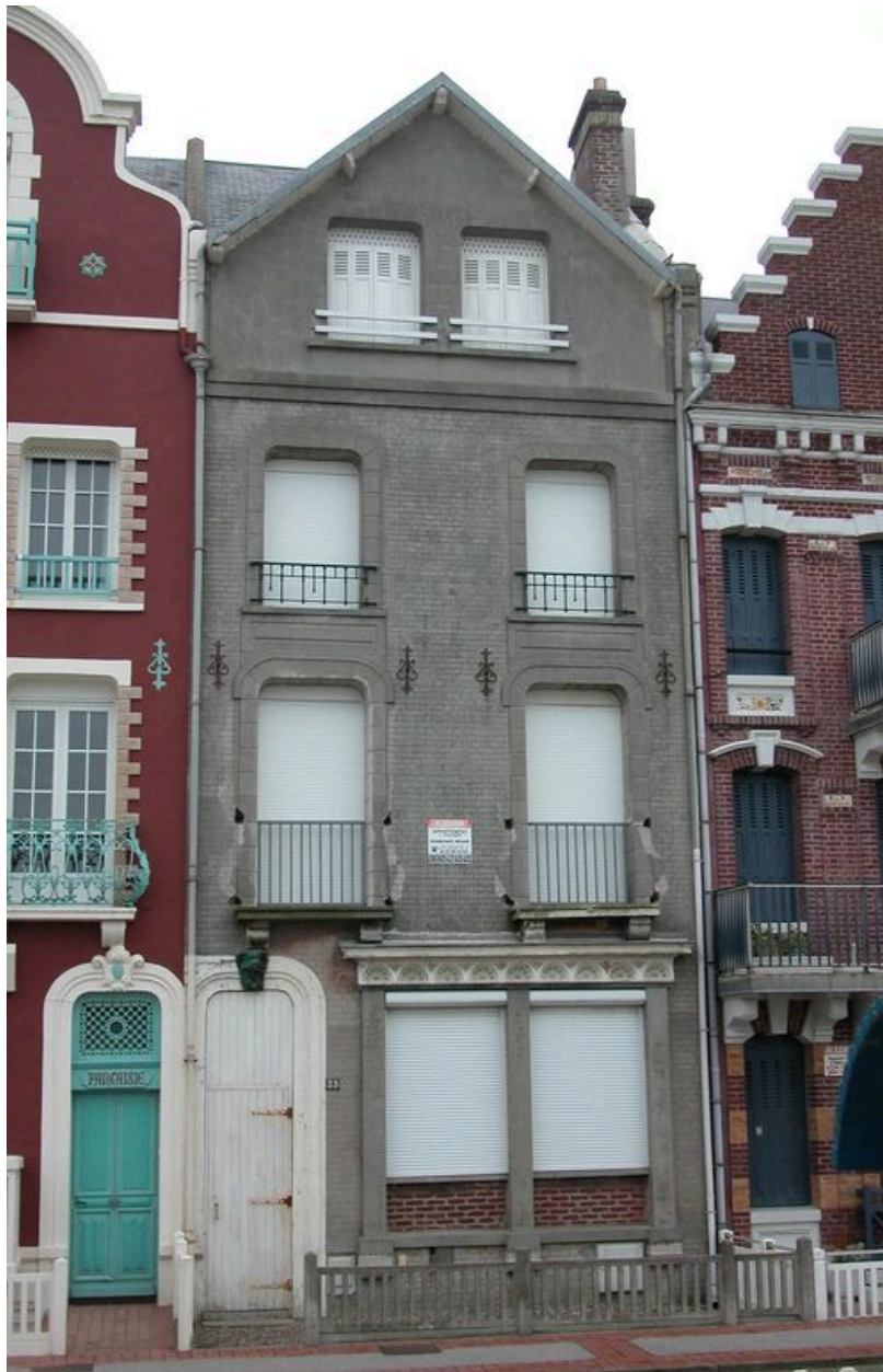
Vue d'ensemble de la maison dite Espana.
