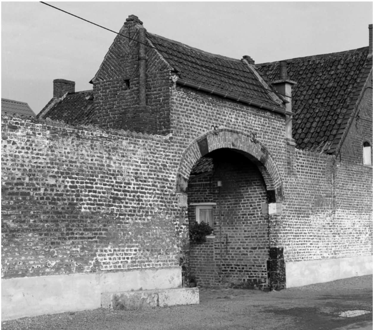
Ferme, 849, rue du Moulin des Ewuelles, le portail.
