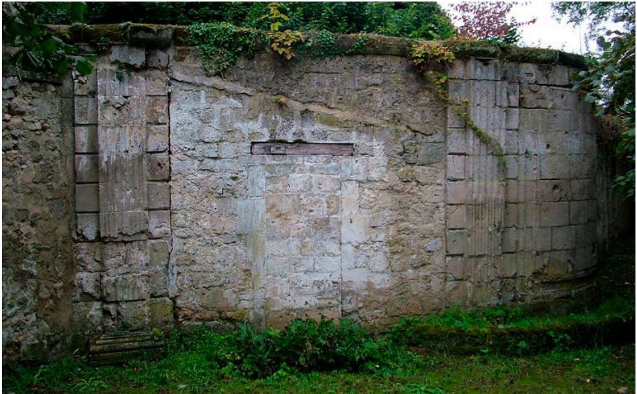
Vue de vestiges de l'ancien portail d'entrée en demi-lune de l'abbaye.
