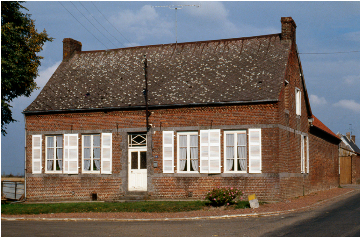
Vue de la façade du logis.
