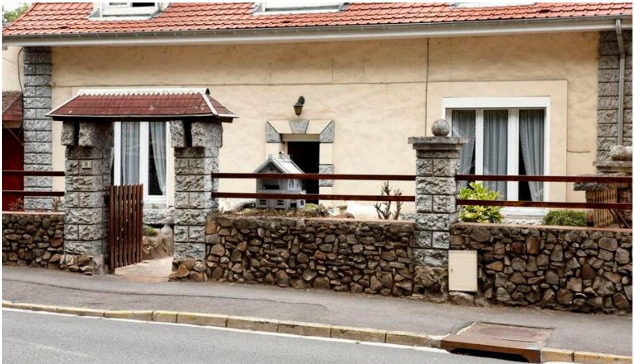
Vue partielle de la façade.
