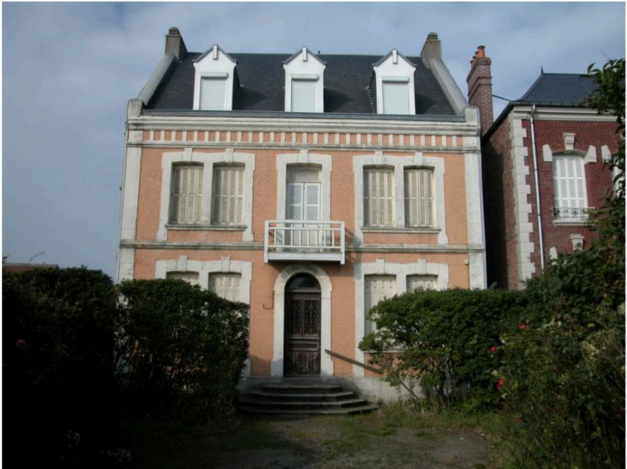
Vue d'ensemble de l'élévation antérieure.
