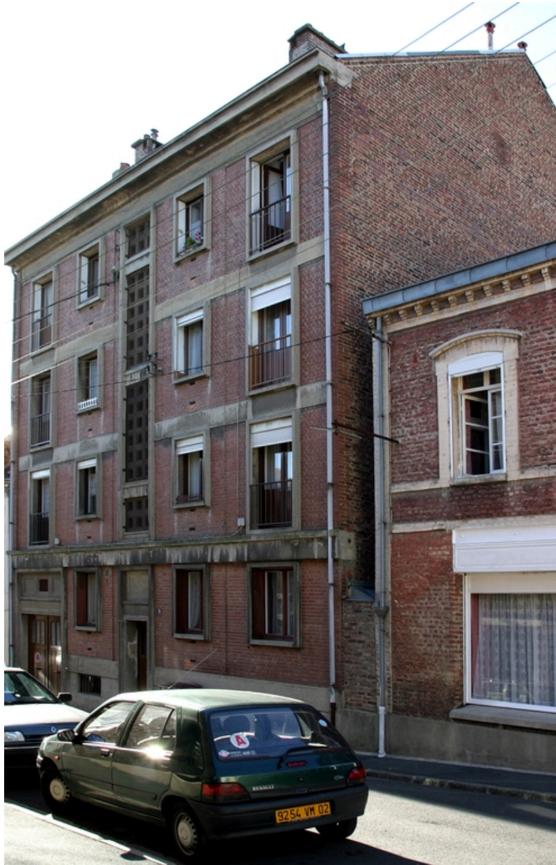
Façade antérieure de l'immeuble d'habitation, rue de Colmar.
