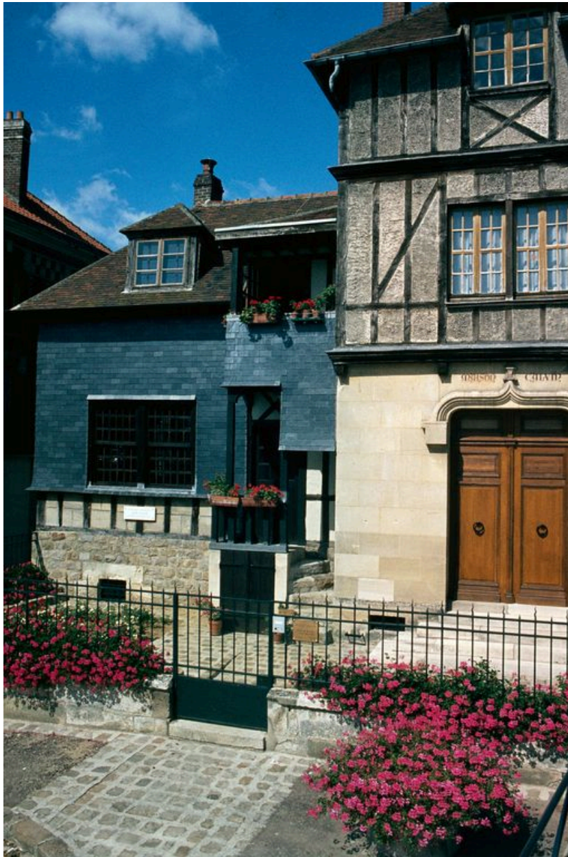
Vue partielle de l'élévation antérieure.
