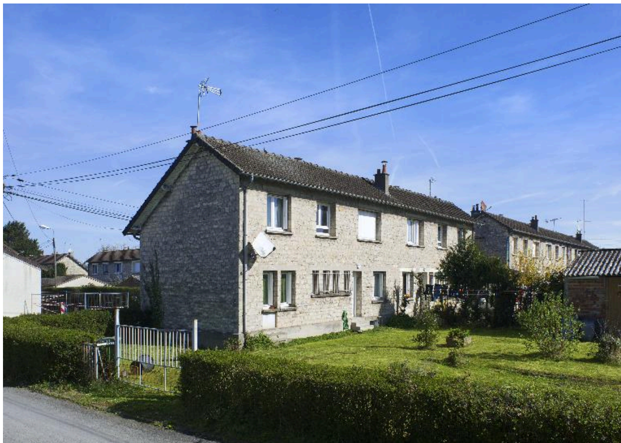
Maison à deux unités d'habitation (4-6 rue de Verdun). Vue de trois-quarts des façades arrière sur jardin, depuis la rue Général-Foch.
