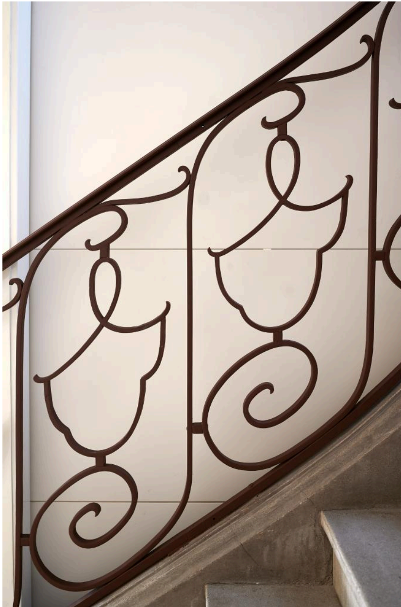
Détail de la rampe d'escalier.
