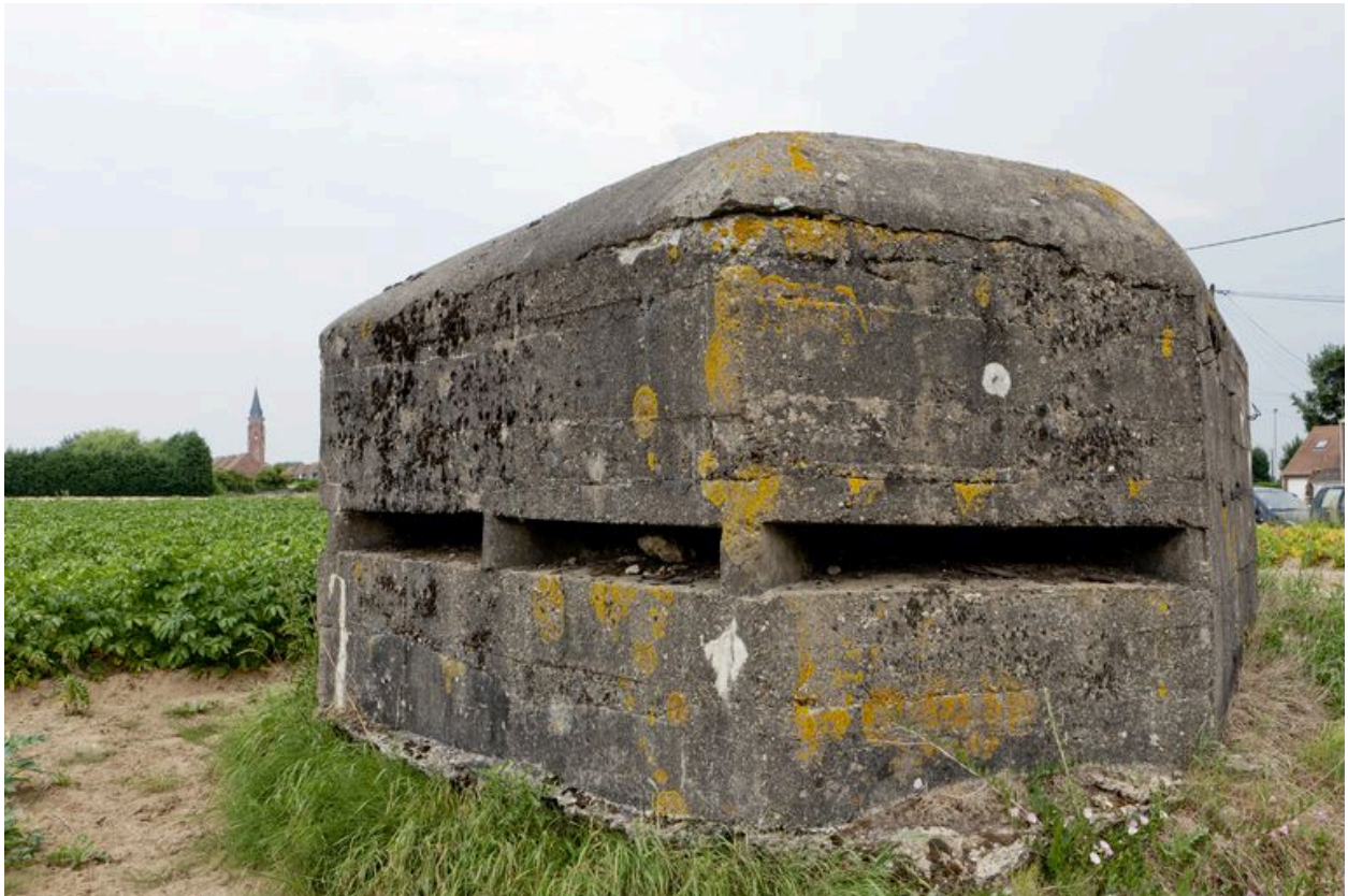
Vue vers le nord-est
