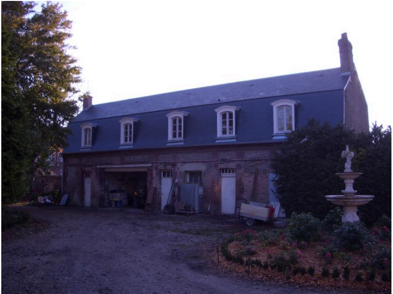
Vue postérieure de la conciergerie.
