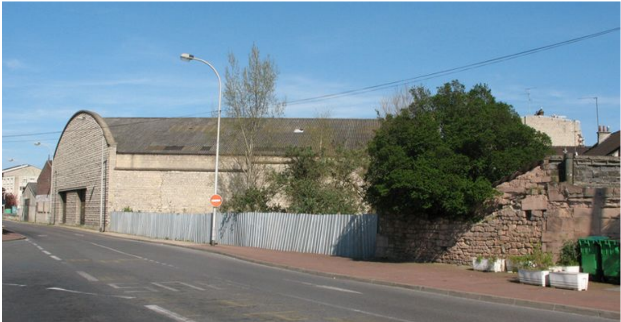
Vue générale des entrepôts depuis la gare.
