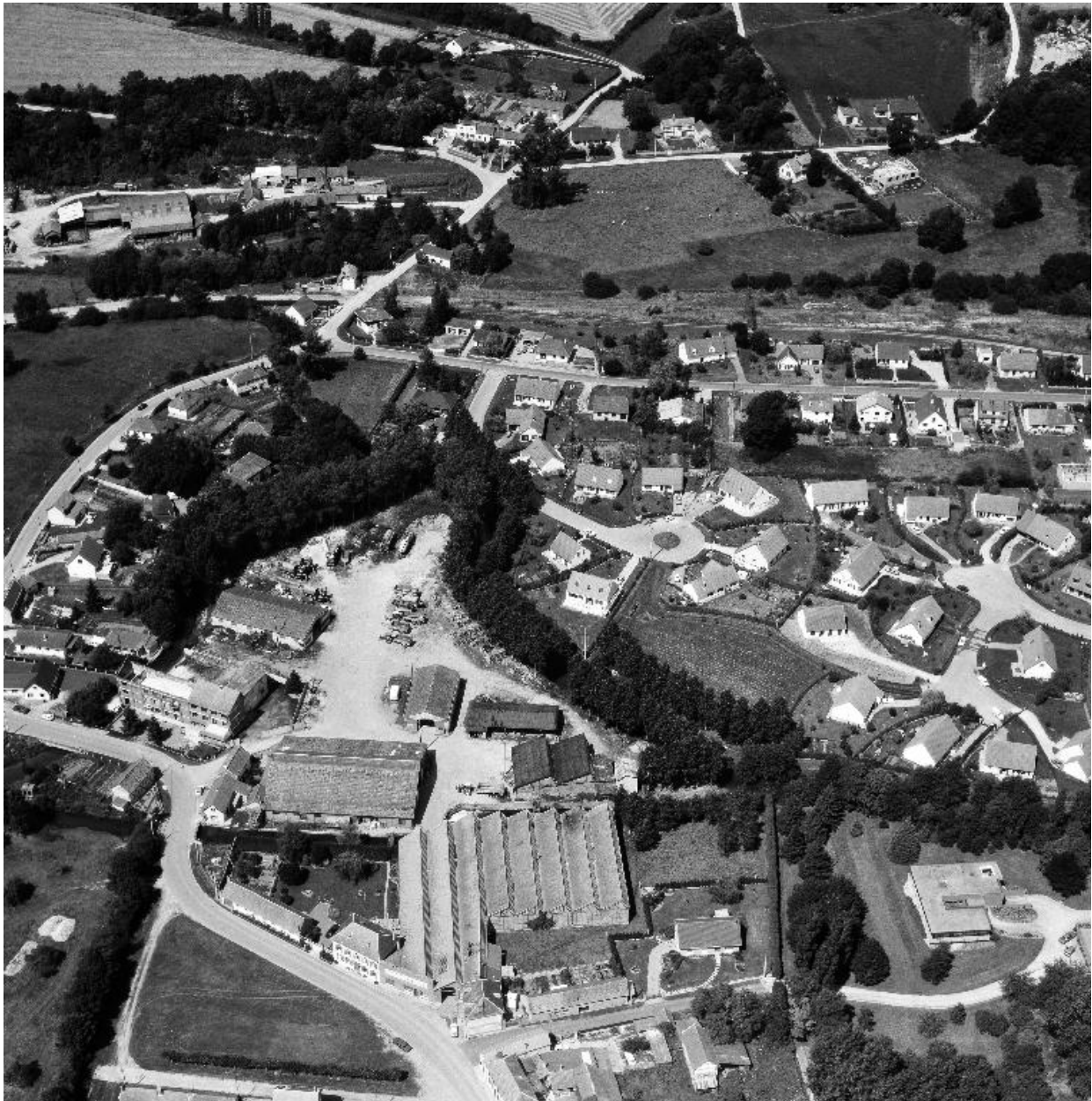
Vue aérienne, flanc ouest.
