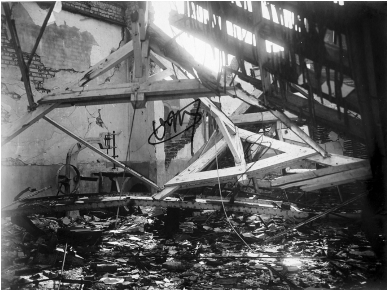
Une partie des ateliers en ruine, vers 1919 (AD Aisne).
