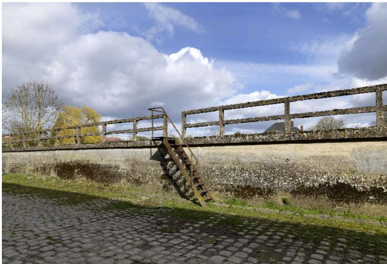
Escalier desservant l'ancienne aire des caniveaux destinés au stockage des betteraves.
