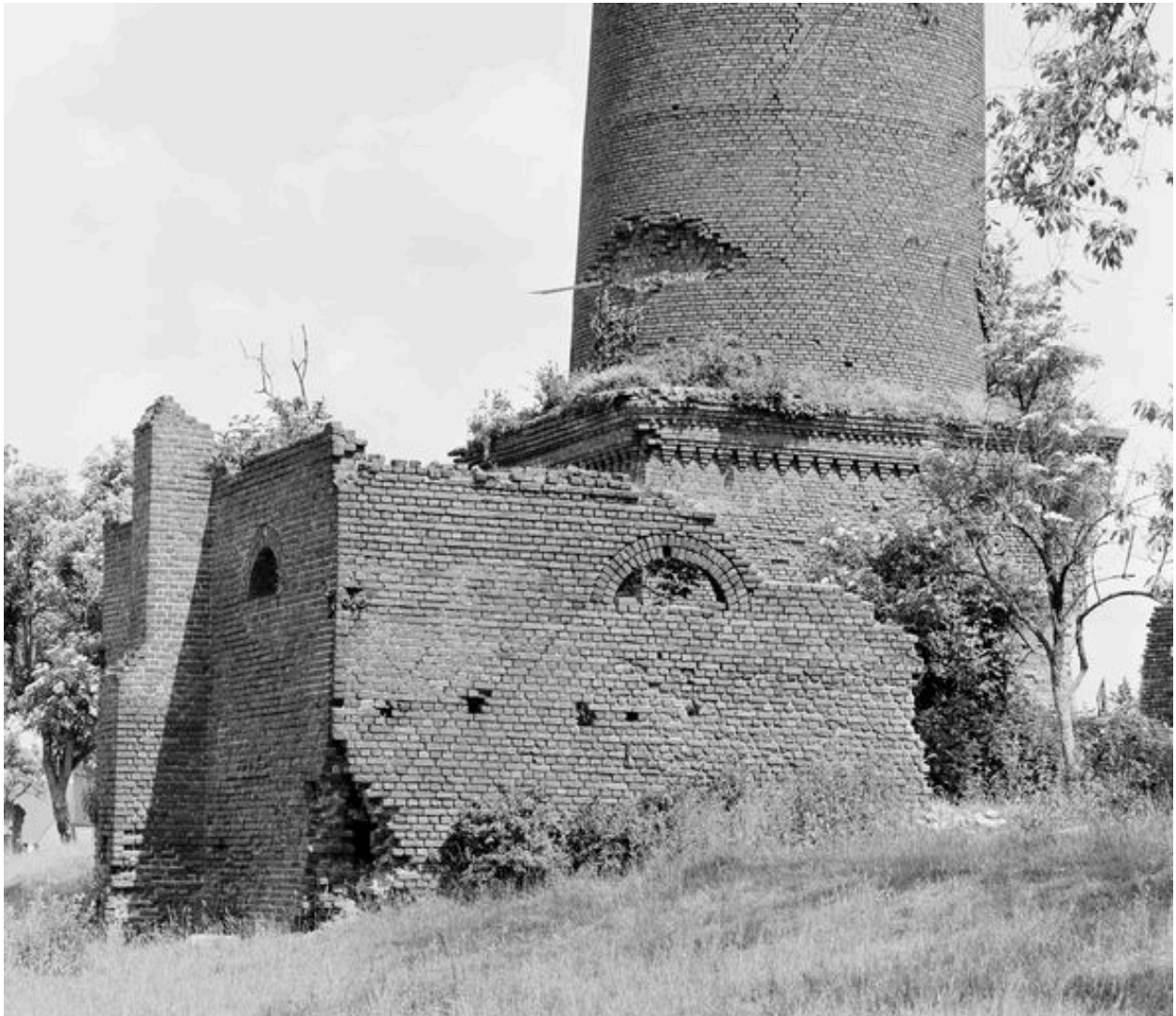
Socle de la cheminée d'usine.
