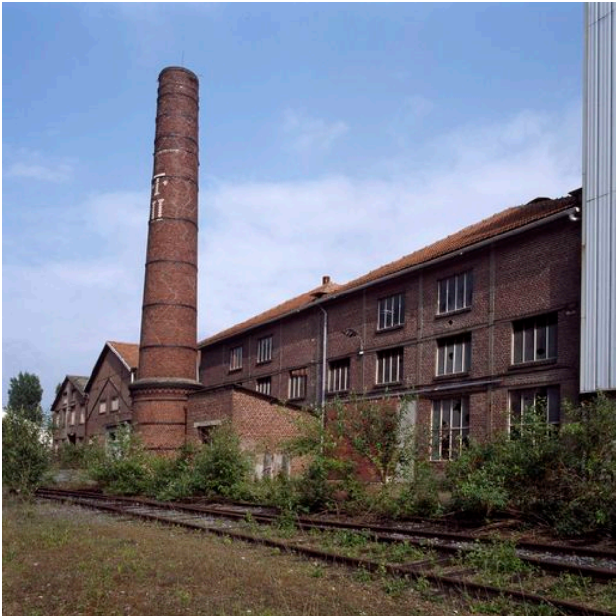
Vue des ateliers côté ferroviaire.
